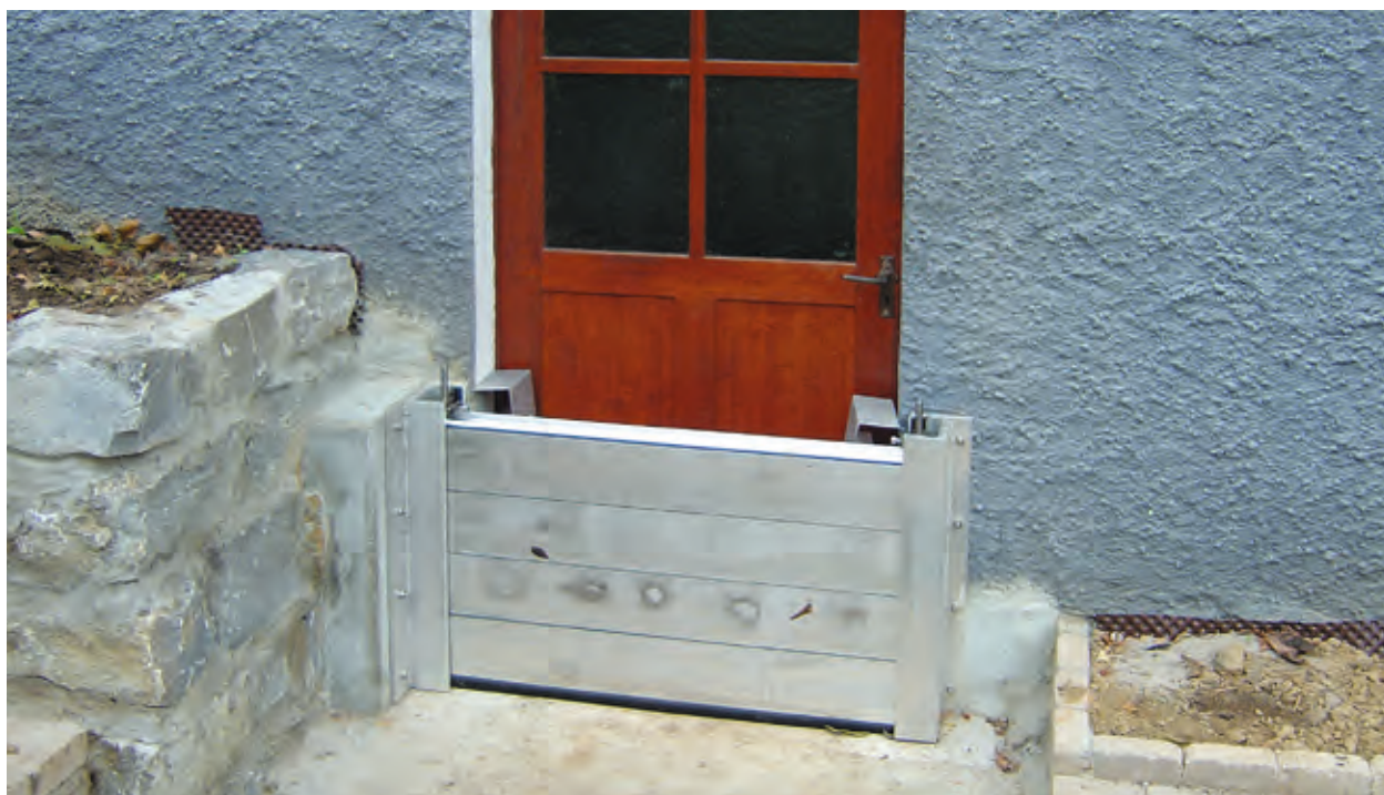
Objektschutz an Gebäudeöffnungen
