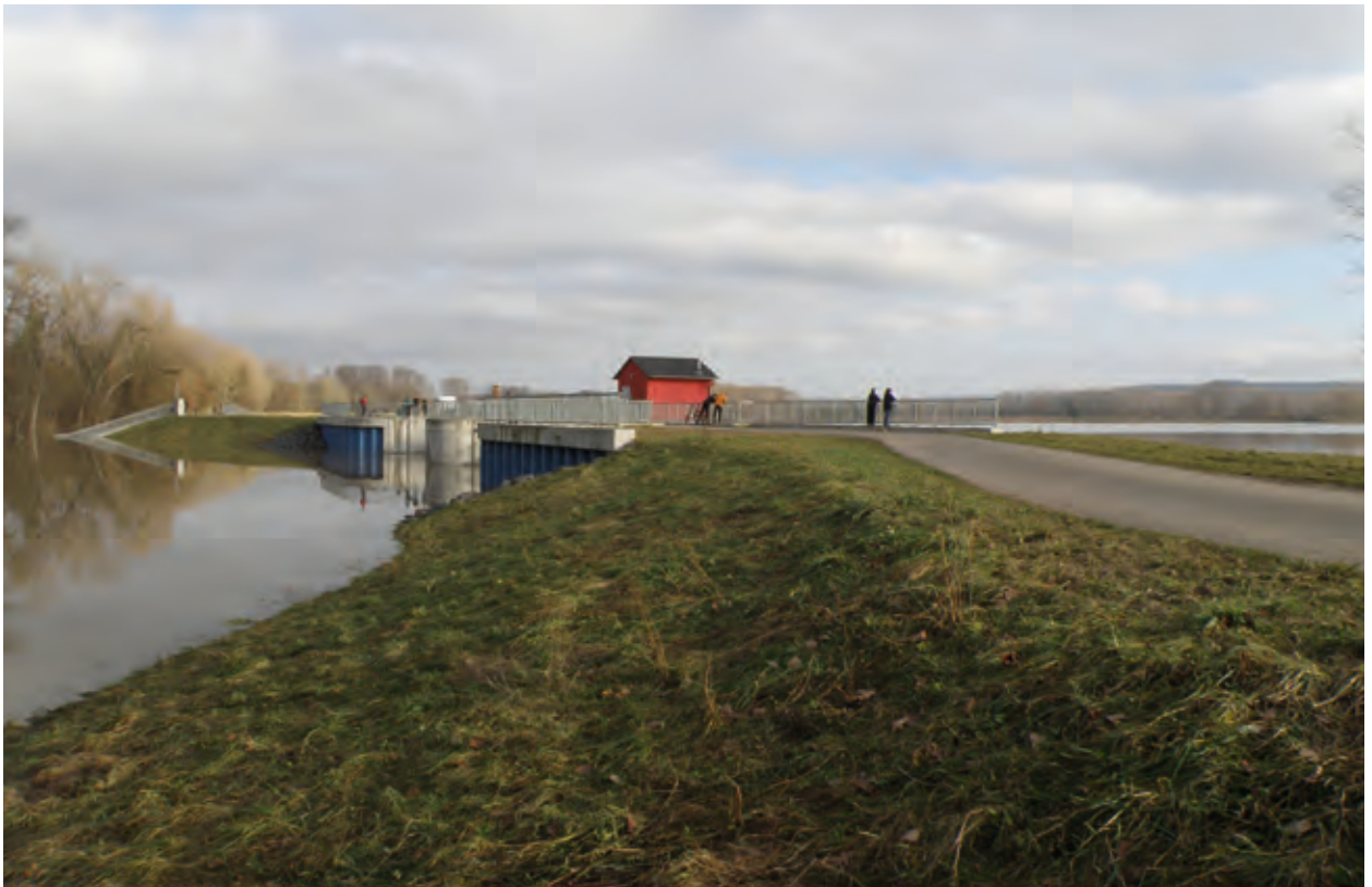
Polderflutung am Rhein bei Ingelheim
