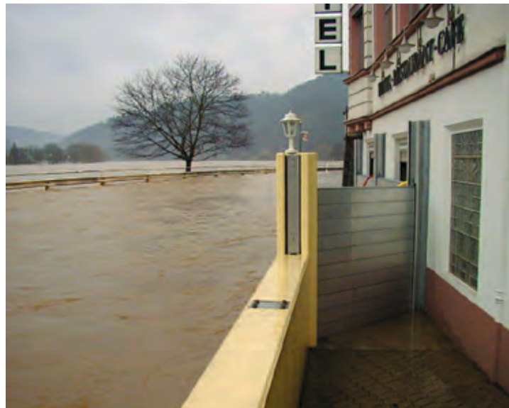
Umlaufender Hochwasserschutz mit teilmobilen Schutzelementen
