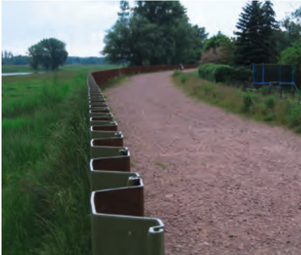
Hochwasserschutzwand mit Stahlpundwand
