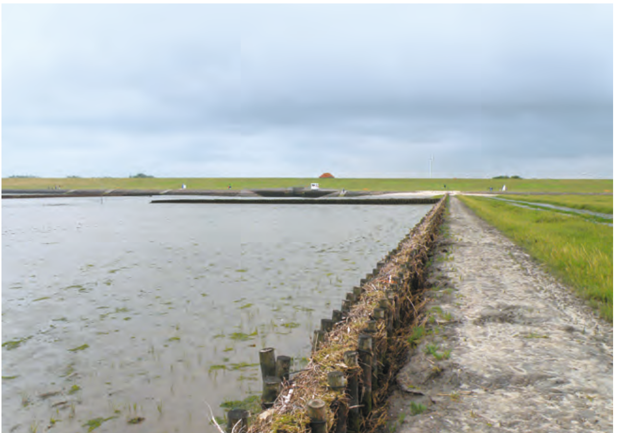
Küstenschutz mit Lahnungen und Hochwasserschutzdeich
